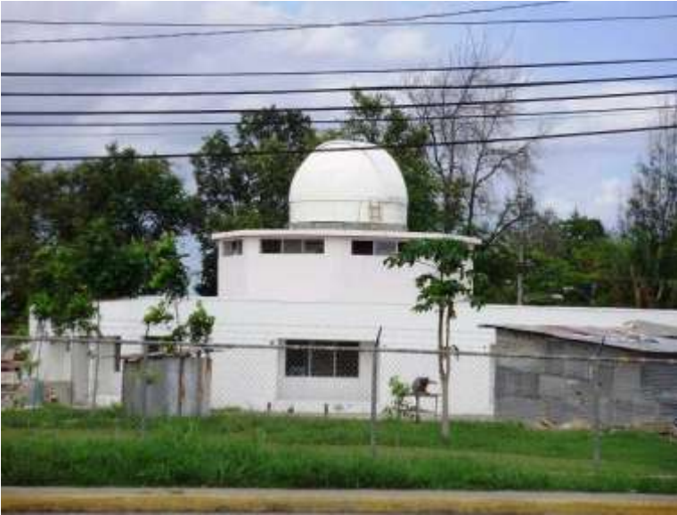
El Centro Astronómico de Penonomé en la etapa constructiva subsiguiente - Web
